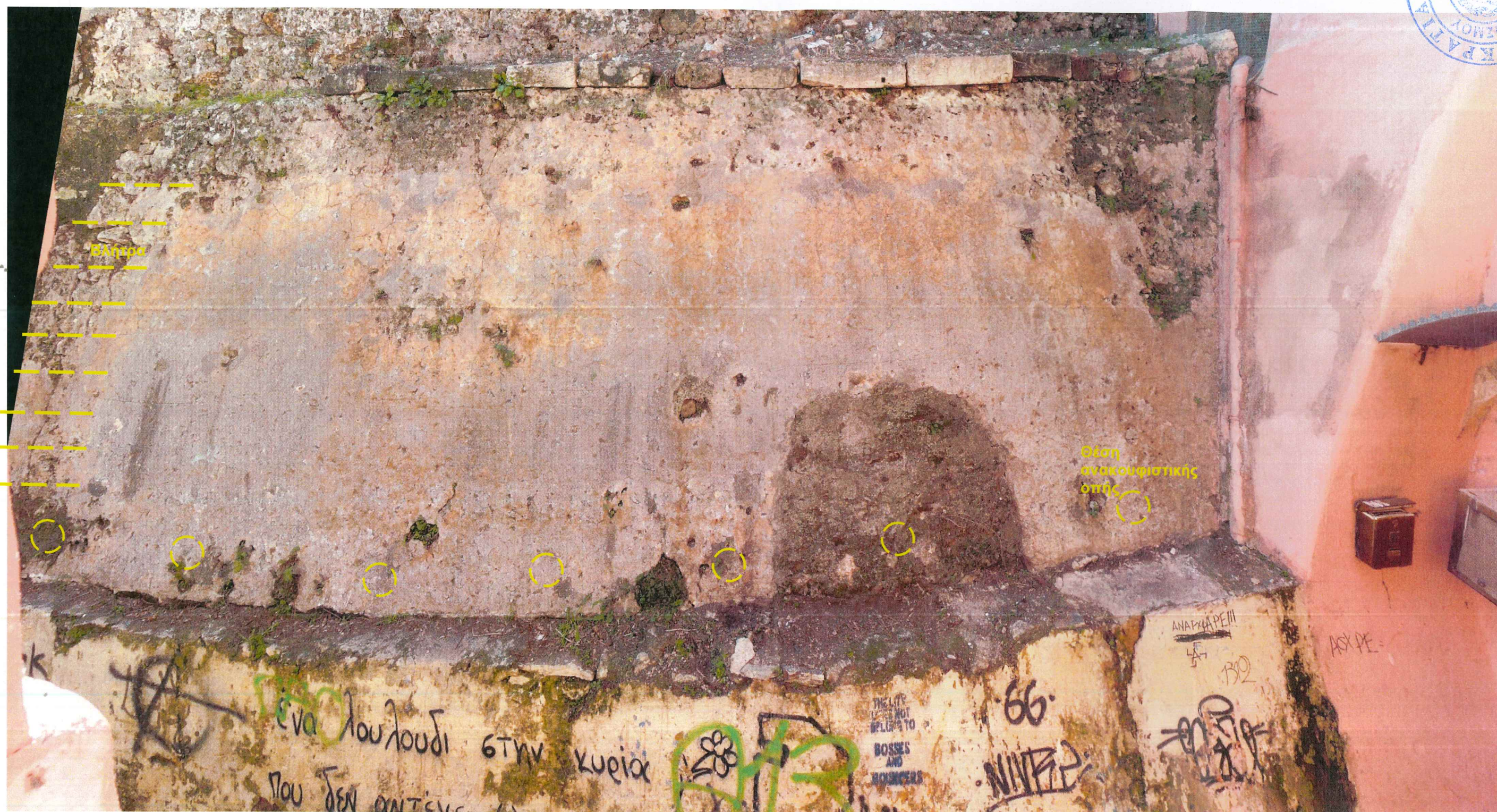
Φωτ. 5.3. Κοντινή άποψη κατώτερου τμήματος τείχους Επιπρωμαχώνα στο στενό τμήμα οδού Πόρτου μεταξύ υφισταμένων κτιρίων σε επαφή με τον Επιπρωμαχώνα. Δείχνονται εντοπισθείσες ρωγμές με διάταξη τοποθέτησης βλήτρων και θέσεις διάνοιξης ανακουφιστικών οπών (ανά 2m περιμέτρου).
