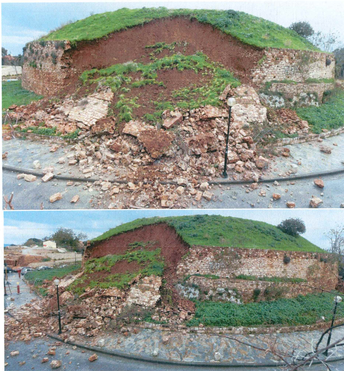
Φωτ. 1.3. Φωτογραφίες της δυτικής αστοχίας του επιπρωμαχώνα τον Φεβρουάριο του 2017 πριν την απομάκρυνση των χωματισμών. Διακρίνεται προς τα δεξιά πλάτυσμα του τείχους το οποίο φαίνεται σήμερα και στην ανατολική πλευρά του σπασμένου τείχους στη δυτική αστοχία.
