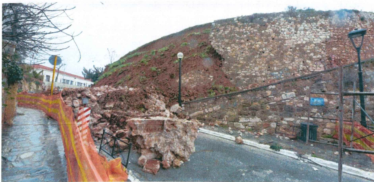
Φωτ. 1.4. Φωτογραφίες της ανατολικής αστοχίας του επιπρομαχώνα τον Φεβρουάριο του 2017 πριν την απομάκρυνση των χωματισμών. Διακρίνεται προς τα δεξιά η περιμετρική ράμπα προς τη στέψη του επιπρομαχώνα.
